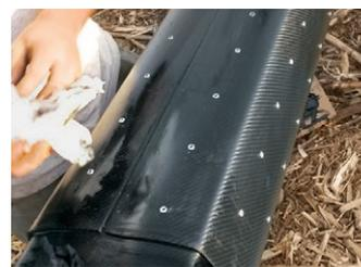
Die im Reparatursatz enthaltenen Carbonplatten werden entsprechend dem Profil der beschädigten Stelle auf die passende Größe zugeschnitten.
